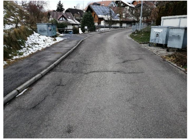
Allgemeinzustand unterer Strassenabschnitt
