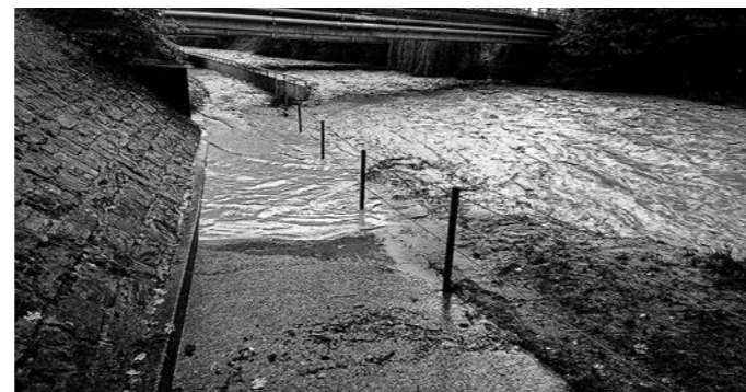
Fussgängerunterführung im Bereich Bahnhof
