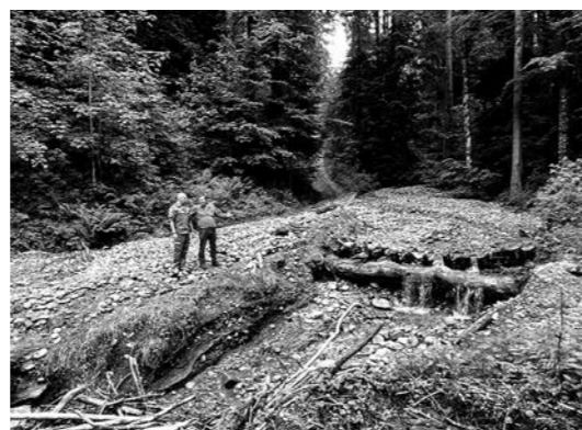
Besichtigung der Schäden mit Gemeindepräsident Wilhelm Balmer
