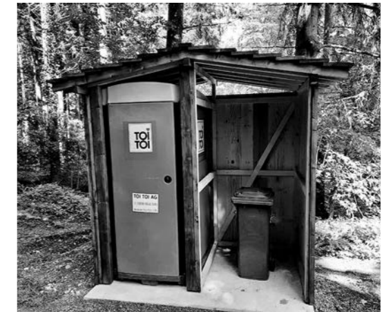
WC in einwandfreiem Zustand
