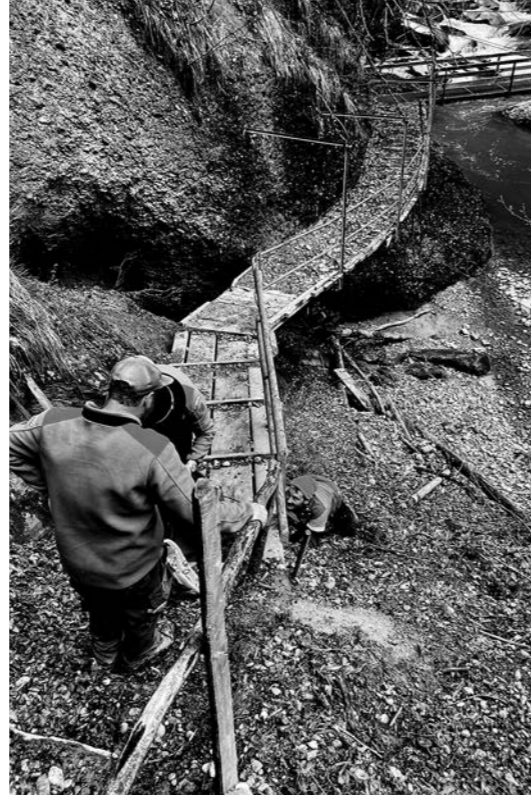
Reparaturarbeiten am Eselsteg
