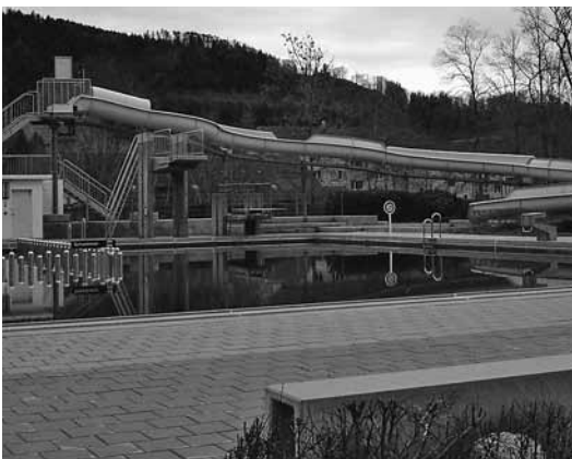
Schwimmbad Steffisburg, neue Rutschbahn
