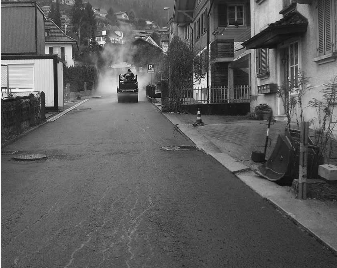
Sanierungs- und Belagsarbeiten Weinbergstrasse
